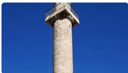
Колонна Траяна · Аполлодор Дамасский
